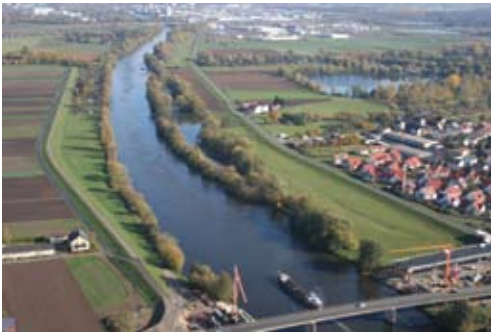
Sanierte Maindeiche bei Grafenrheinfeld, Lkr. Schweinfurt
