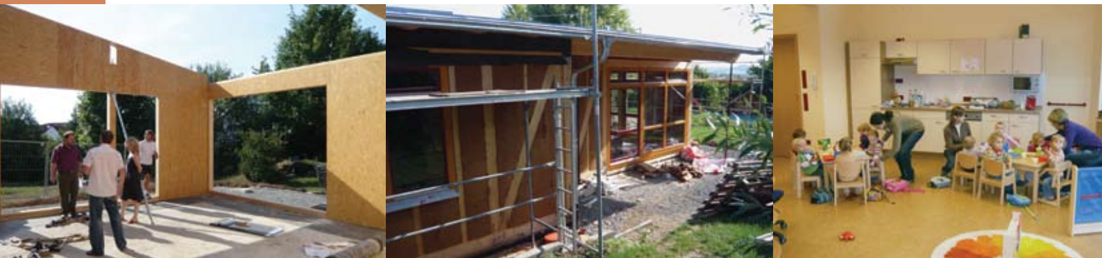
Der Anbau (Neubau) der Kinderkrippe an den katholischen Kindergarten St. Barbara in Haßfurt in seiner Entwicklung (Fotos: Stadt Haßfurt).
