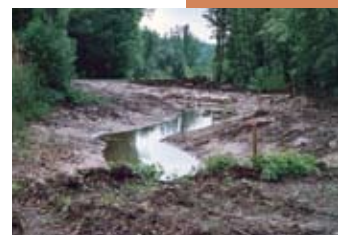
Umgehungsgerinne in Bau (Herbst 2007)
