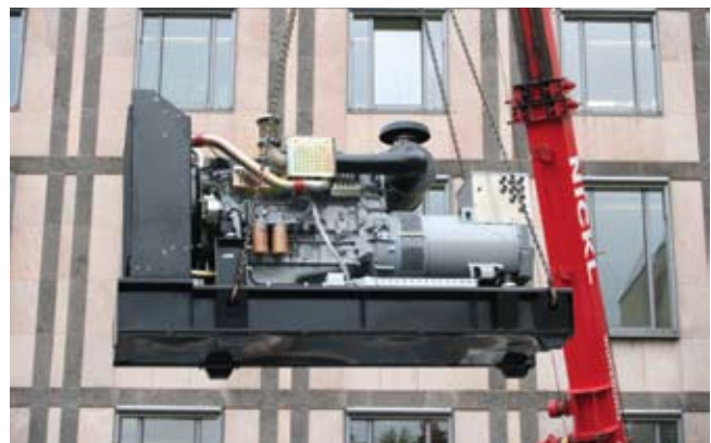
Neues Notstromaggregat bei der Anlieferung
